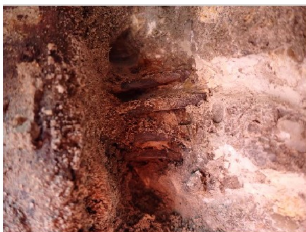
27 koroze kotvy N11 op2.JPG
