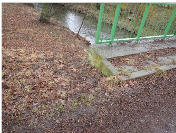
21 odplavení zemního tělesa za op2 vpravo.JPG
