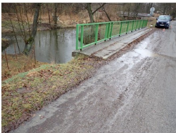
19 odplavení zemiho tělesa před op1 vlevo.JPG
