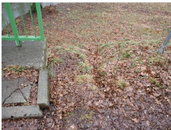
20 odplavení zemního tělesa za op2 vlevo.JPG
