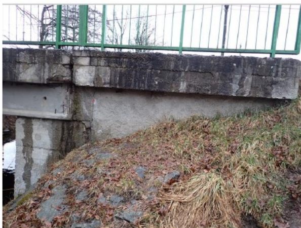
17 vytékání vody OP2 vpravo.JPG
