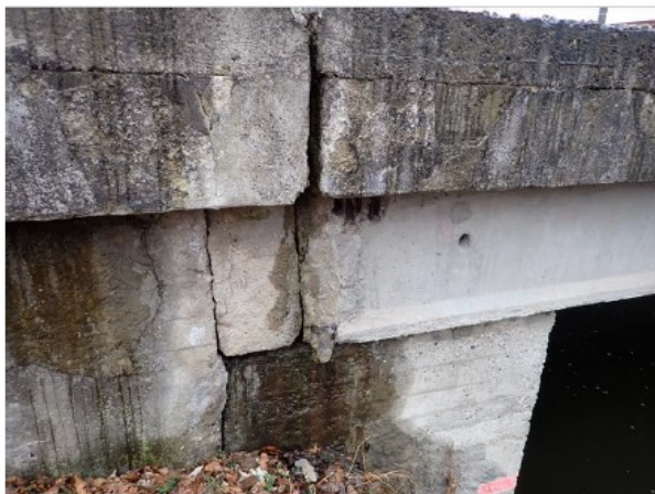
16 vytékání vody OP2 vlevo.JPG
